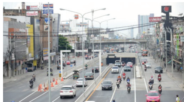
ภาพ 2 อุโมงค์ลอดทางแยกมไหสวรรย์
