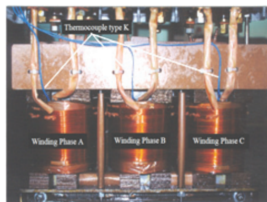
ภาพ 16 ภาพจริงการติดตั้งเทอร์โมคัปเปิลที่ขดลวดปฐมภูมิและขดลวดทุติยภูมิ
