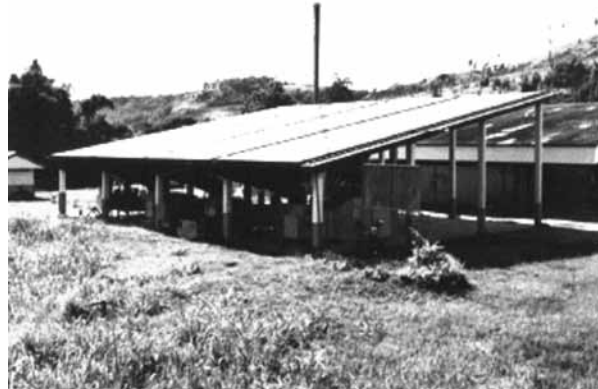
ภาพ 6 เครื่องอบแห้งที่มีการพาความร้อนแบบบังคับที่มา.จาก “เครื่องอบแห้งพลังงานแสงอาทิตย์แบบอุโมงค์เพื่อใช้ในการแปรรูปผลิตภัณฑ์ทางการเกษตร,” โดย วัฒนพงษ์ รัชวิเชียร, ปี 2544, ภาควิชาฟิสิกส์ คณะวิทยาศาสตร์ มหาวิทยาลัยนเรศวร.
