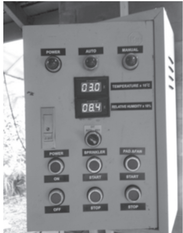
ภาพ 6 การติดตั้งอุปกรณ์ภายนอกตู้ควบคุม
